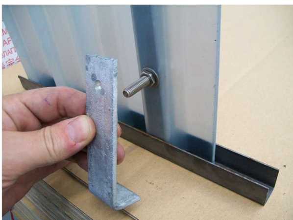
Introduire la patte de fixation de serrage sur cornière
